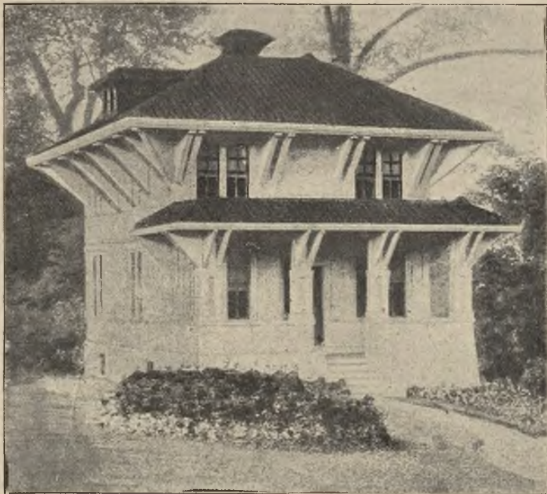
Domy z cementu: Dom Edisona, odlany w całości z cementu.
