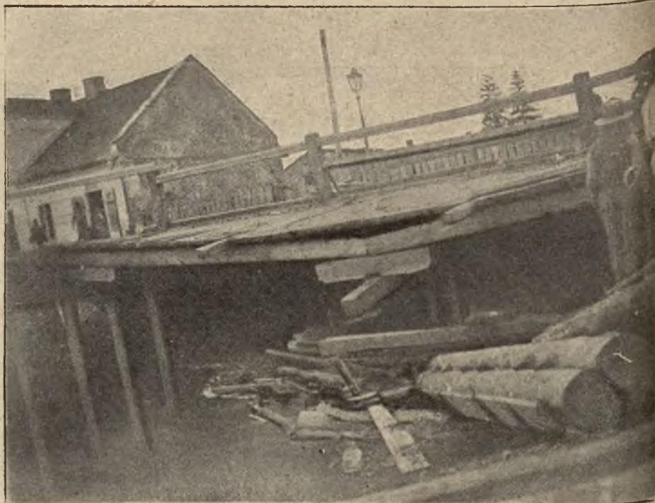
Kołomyja pod wodą: Zburzony przez wylew Czaray Potoku most w ul. Sobieskiego
