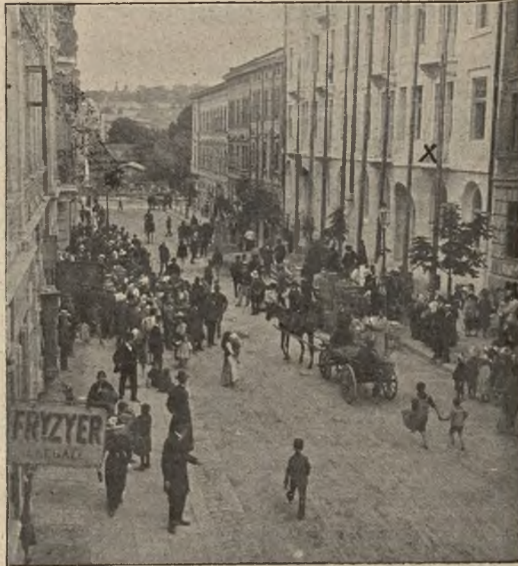
Znowu katastrofa budowlana we Lwowie: Dom przy ulicy Kleparowskiej, (X) w którym wydarzyła się katastrofa. (Fot. M. Münz, Lwów).
