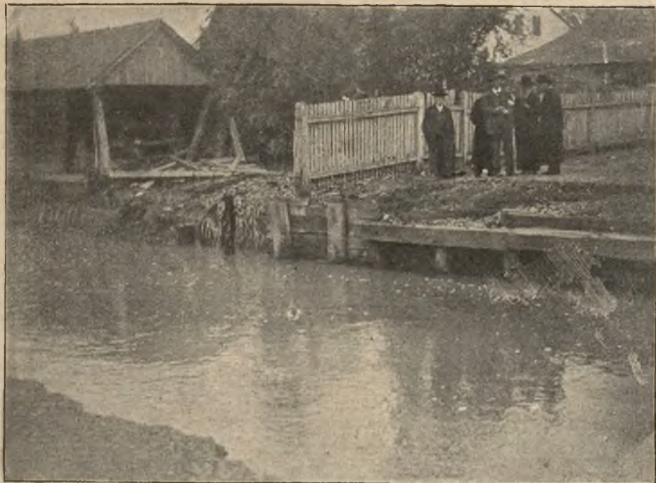
Kołomyja pod wodą: Czaray Potok i uszkodzone przez powódź domy na ulicy Bednarskiej.
