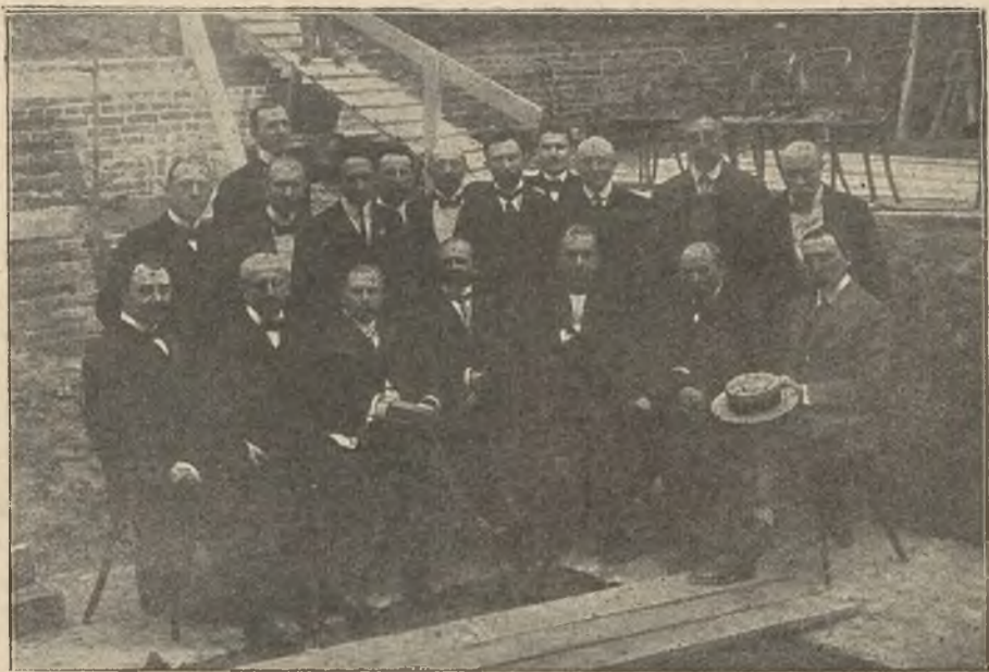
We własnej siedzibie: Grupa członków komisji budowlanej i zarządu „Stow. pracowników handlowych wyznania Mojżeszowego” w Warszawie.
