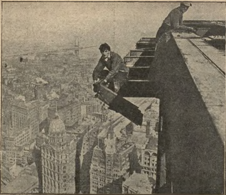
Budowa „drapaczy nieba“: Robotnicy zakładają belki sufitowe na wysokości pięćdziesiątego piętra.
