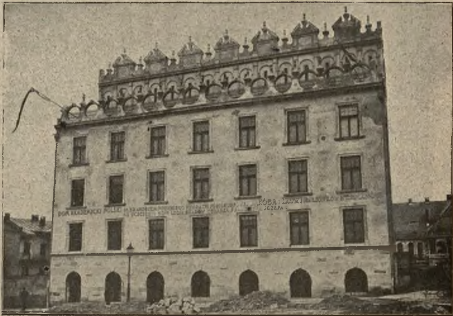
Dla polskiej młodzieży: Budynek nowego Domu akademickiego im. Andrzeja hr. Potockiego we Lwowie. (Fot. M. Münz, Lwów).
