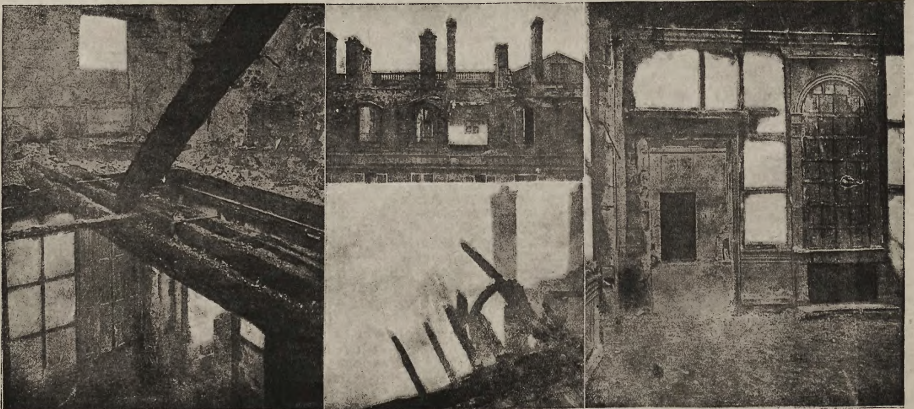
Pożar zamku Napoleona I. 1) Sufit ponad pokojem cesarza zniszczony przez pożar. 2) Widok na spalone wiązania dachu. 3) Dach ponad salą Rady. 4) Zniszczona sala położona obok pokoju cesarza.
