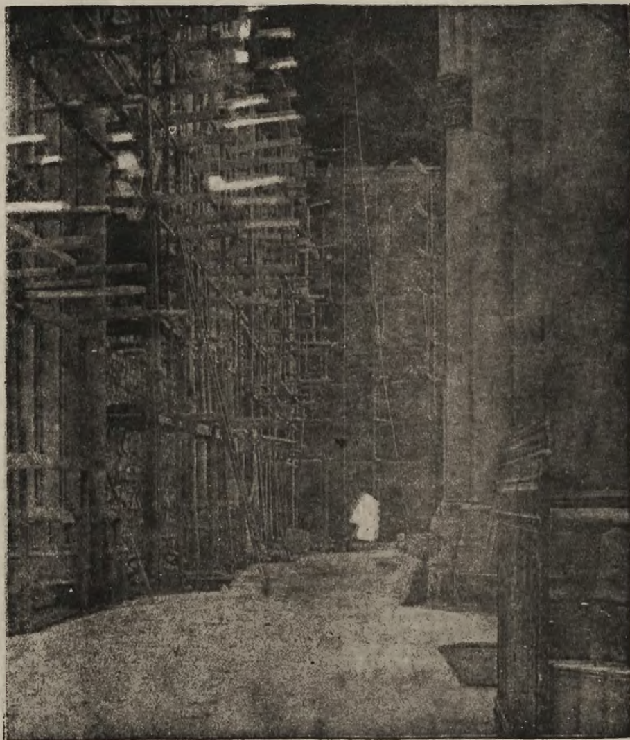
Odbudowa katedry w Reims : Rusztowania w katedrze w Reims, w czasie robót restauracyjnych.
