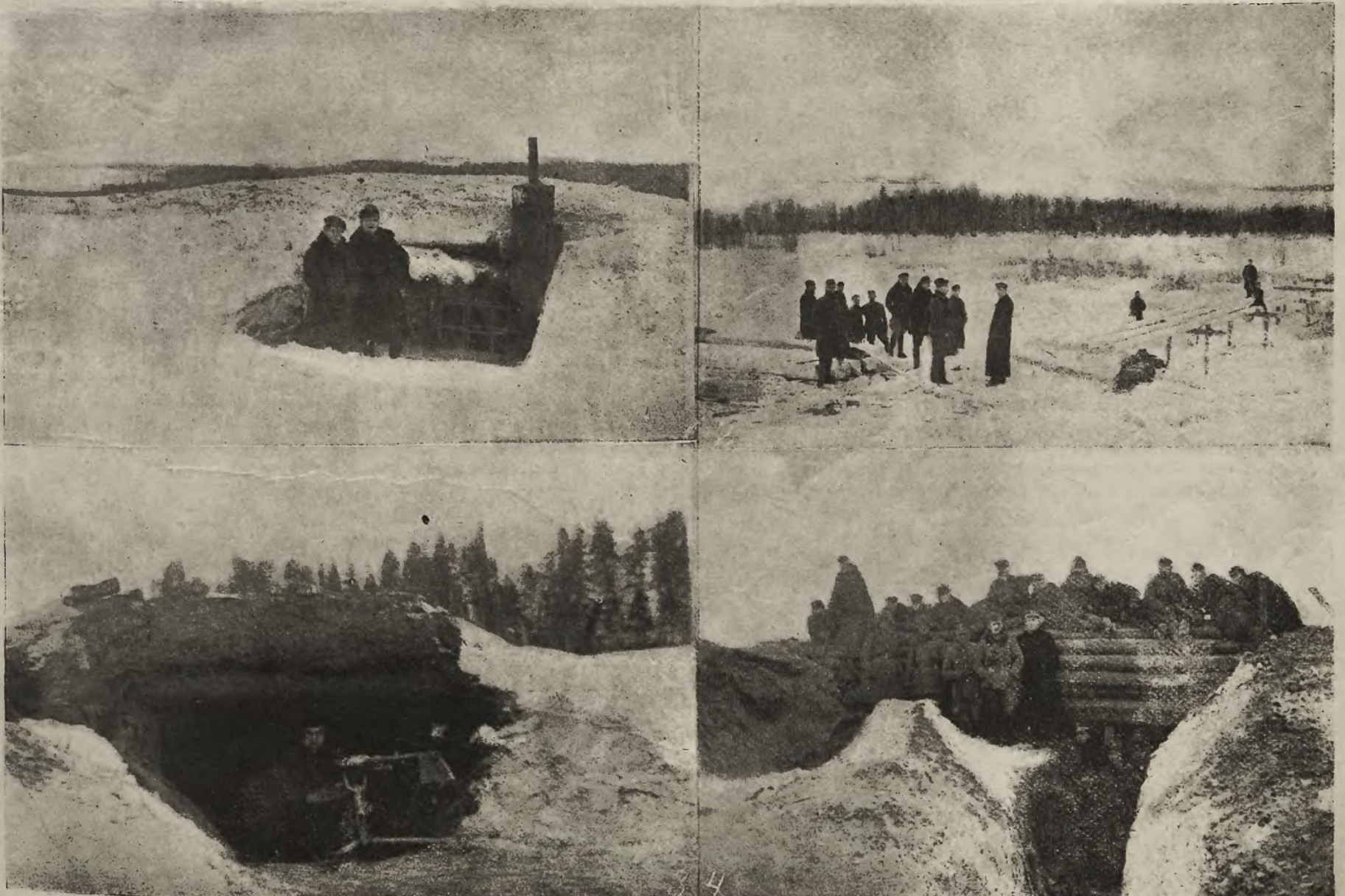
Na wschodnim froncie: 1) Zemianka na odcinku jednej z kompanii III batalionu 13 p. p. 2) Budowa mostu na odcinku III batalionu. 3) Stanowisko karabinów maszynowych. 4) Zemianka na pozycji 9 kompanii (X) dow. III baonu por. Esterlein (XX) dow. komp. ppor. (XXX) kapitan pułku X. Kasiewicz.
