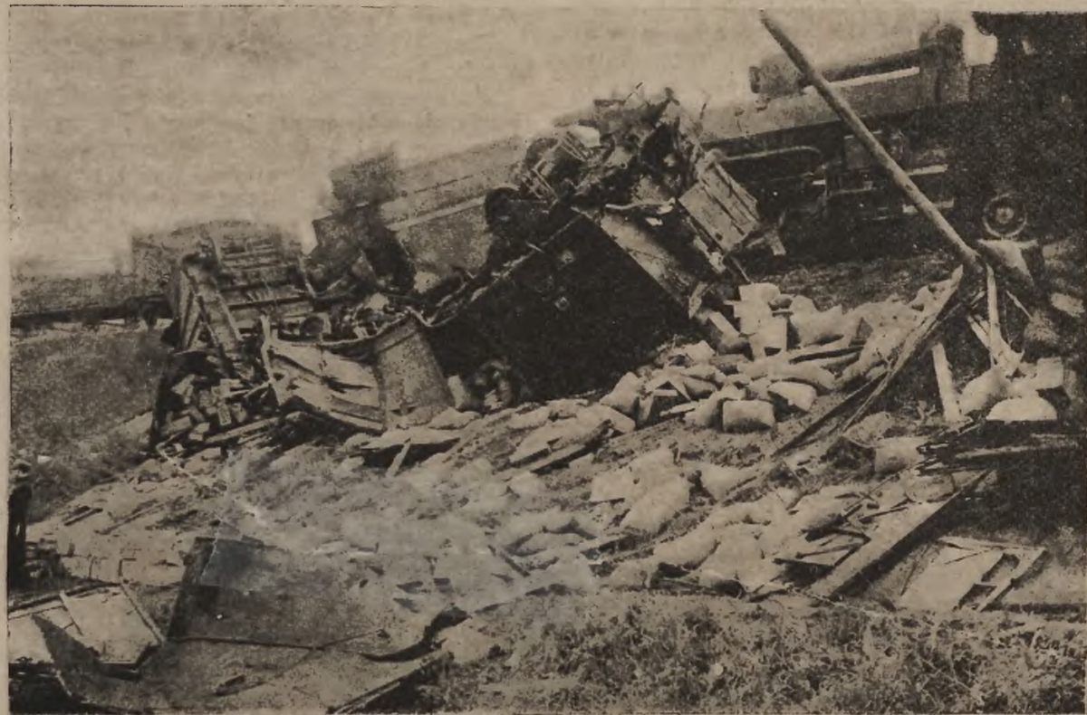
Katastrofa kolejowa pod Jarostawiem: Rozbite wagony pociągu towarowego.
