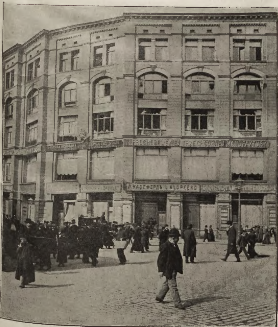
Nowa bomba w Warszawie: Część ogromnego gmachu Simonsa z biurami kolei Nadwiślańskich na końcu ul. Bielańskiej, z którego większość szyb wypadła skutkiem wybuchu bomby w czasie zamachu na naczelnika ruchu kolei Nadwiślańskich Proskurjakowa na ulicy przed gmachem.
