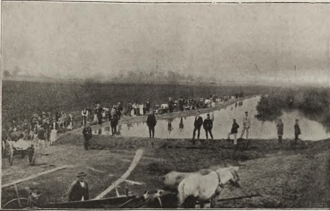
Wylew rzek w powiecie tarnobrzeskim: Prace na wałach ochronnych przy Sanie pod Rzeczą Długą, w chwili, kiedy woda już opadała. Na wale z przodu 1. hr. Lasocki, starosta tarnobrzeski, 2. Inżynier Stein, 3. Naczelnik straży ogniowej M. Kanarek, 4. P. Baraniecki, 5. B. Kanarek, członkowie akcji ratunkowej.
