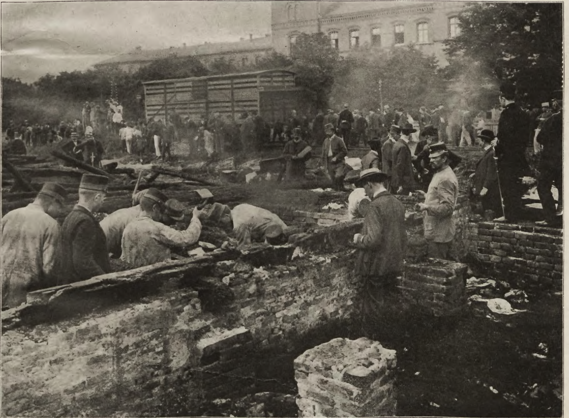
Fot. dla „Now. Illustr.“ aparatem red. W. Lis. Olbrzymi pożar w Krakowie: W parę godzin po nocnej katastrofie, komisje zwiedzają szczegółowo pogorzelisko magazynów kolejowych, dla określenia w przybliżeniu strat milionowych; na pierwszym planie strażnicy przeszukują zniszczony transport cukru miałkiego, w którym znajdują kilkaset przepalonych rewolwerów-Brauningów, przemycających do Królestwa Polskiego.
