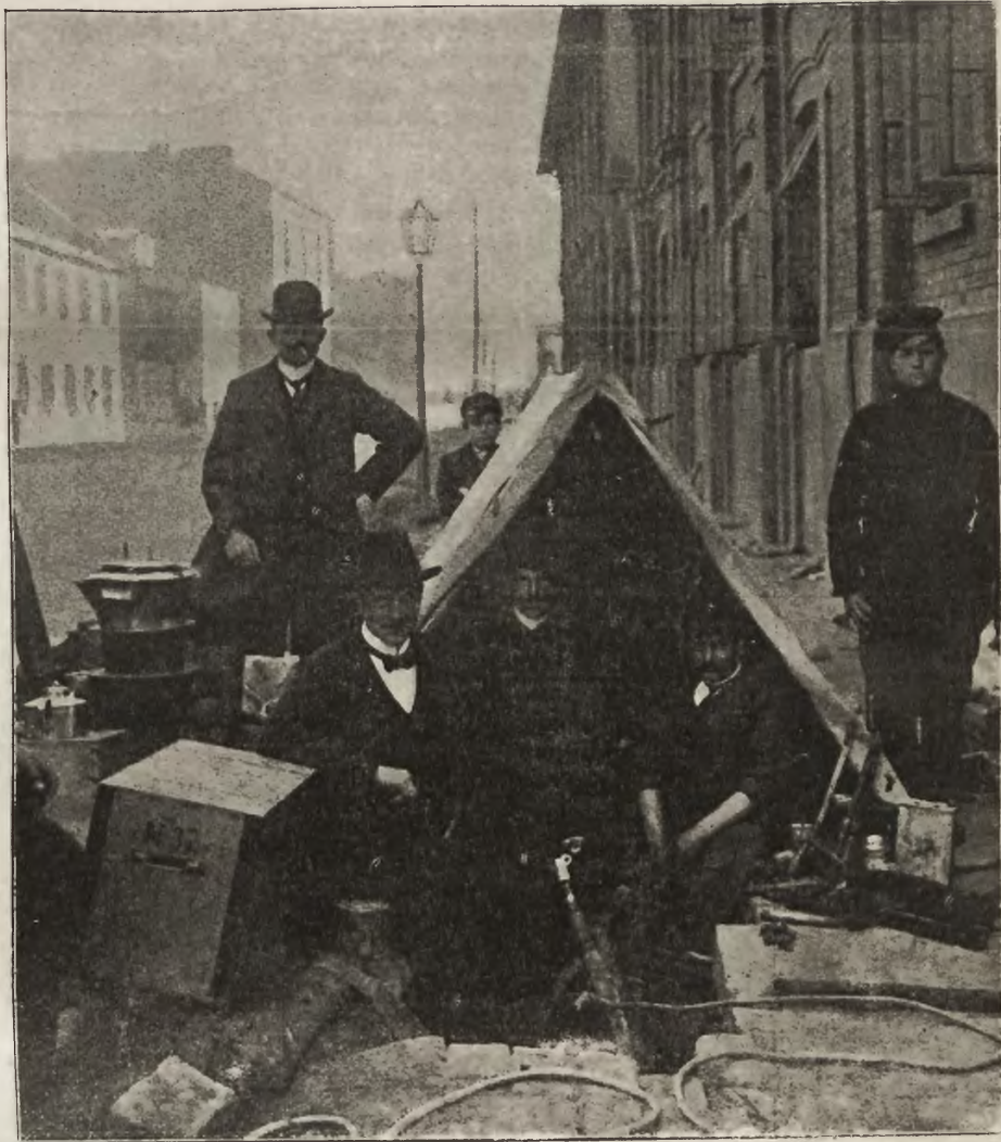
Budowa tramwajów pod ochroną wojskową: Przerabianie linii tramwajów konnych w Warszawie na elektryczne pod osłoną patroli wojskowych ze względu na ciągłe strejki; łączenie końców poszczególnych kabli.
