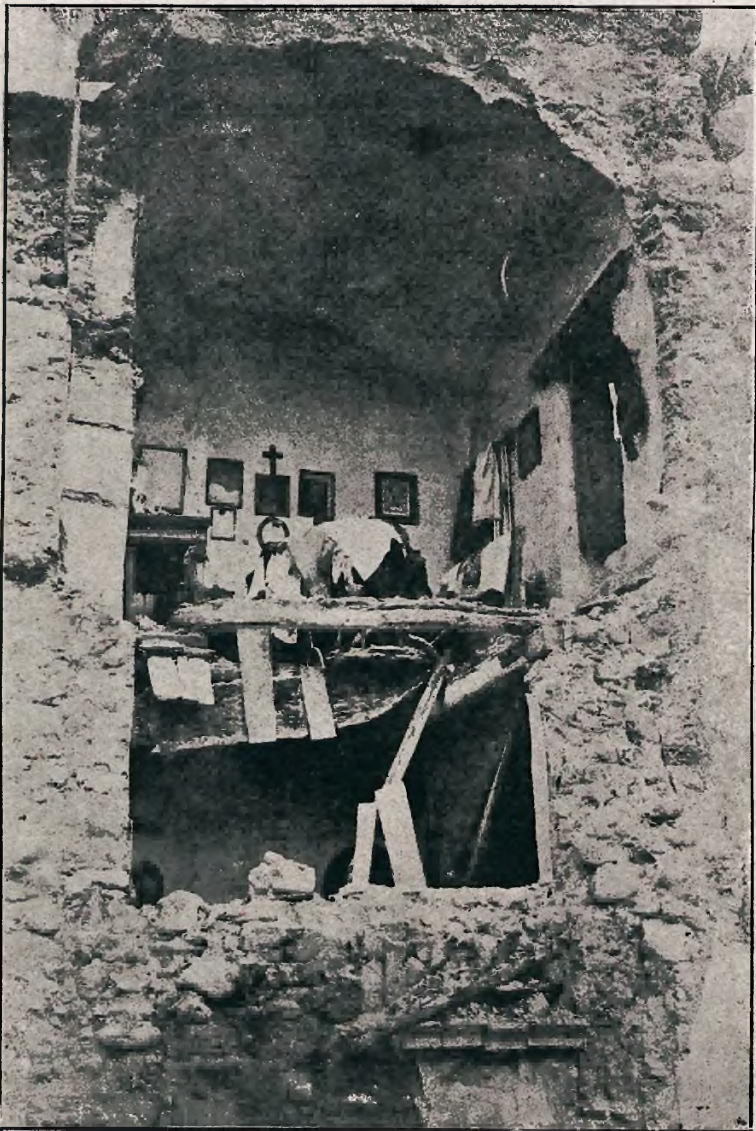
Gruzy i zgliszcza: Wnętrze domu zburzonego przy via S. Liberale w Messynie.
