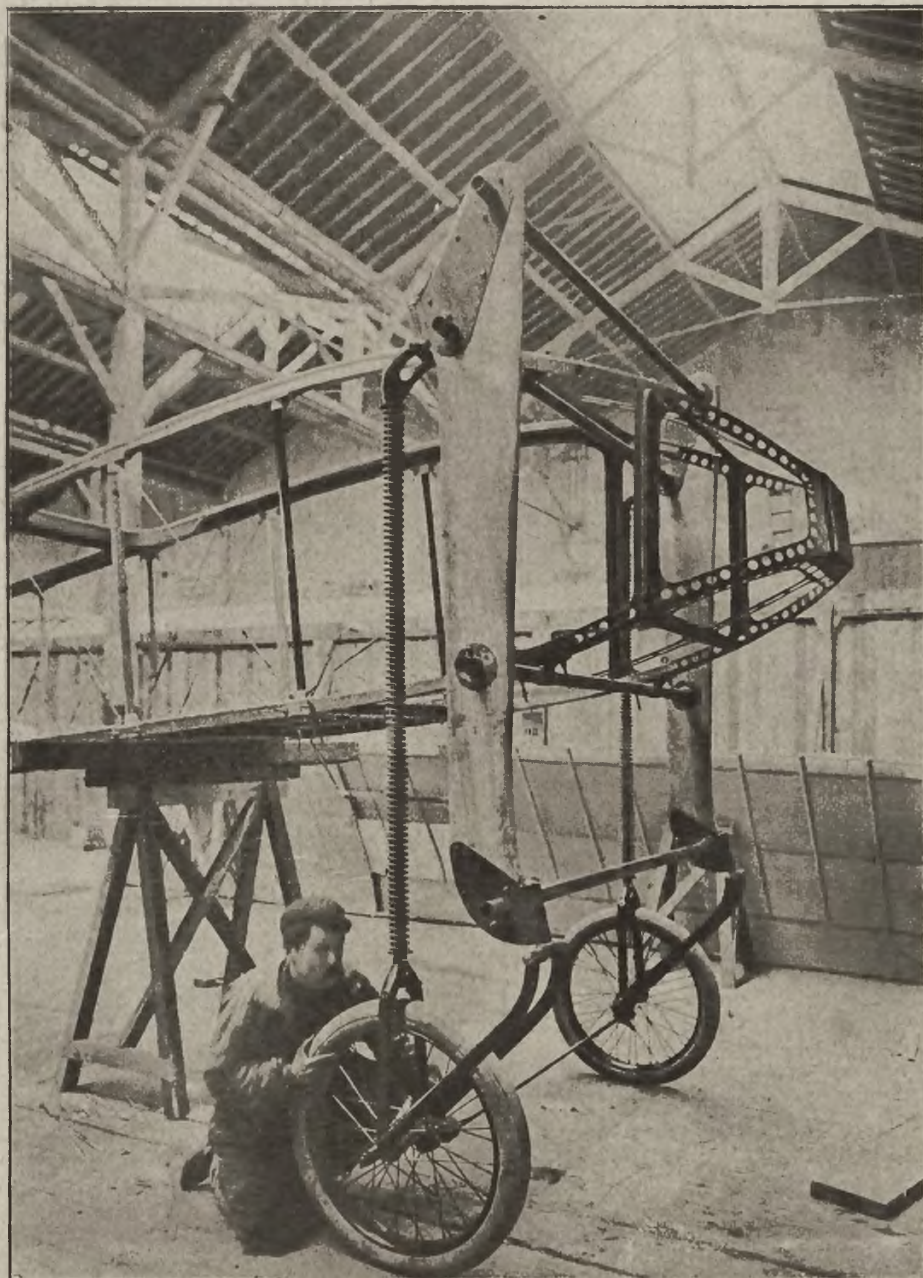
Budowa aeroplanu: Wnętrze warsztatu z żelazną konstrukcją przyszłego aeroplanu.
