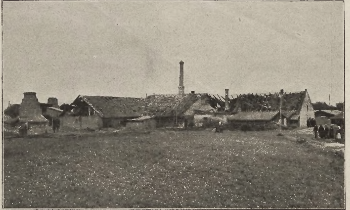
Straszny wybuch prochowni: Zniszczone zabudowania fabryki gipsu na „Słomówce“.
