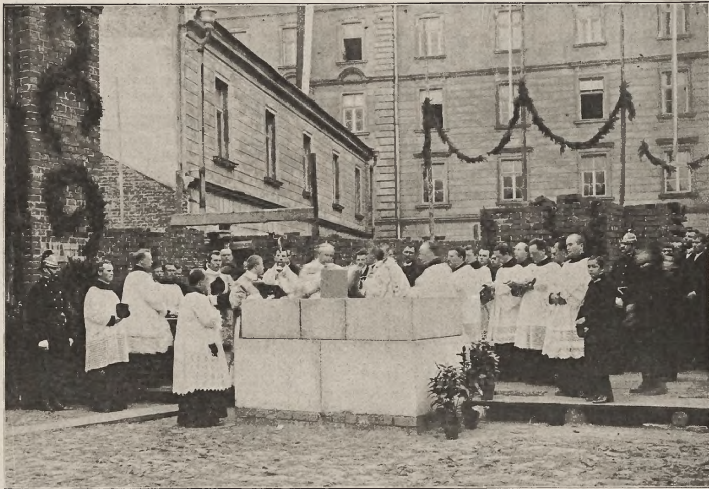
Budowa nowego kościoła w Krakowie: Akt poświęcenia kamienia węgielnego.
