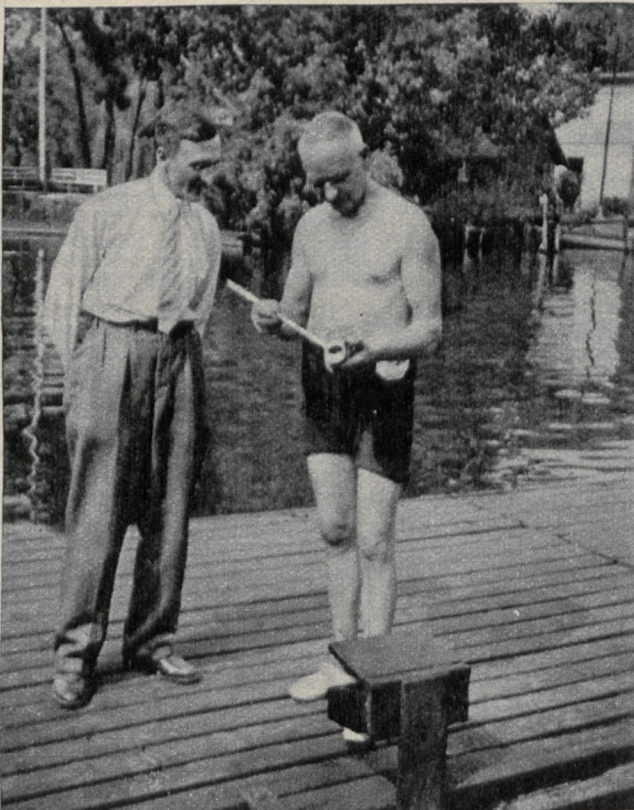
Ciekawy pomysł Hugona Bormana przy umocowaniu dułki: bolec przedłużony wydatnie ku dołowi i umocowany podwójnie wzmocnionem ramieniem.
