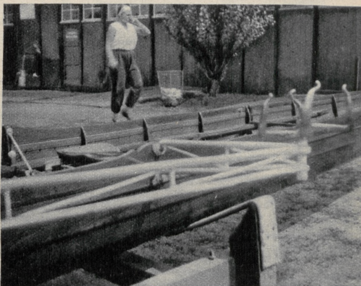
Ciekawy pomysł Hugona Bormana przy umocowaniu dułki: bolec przedłużony wydatnie ku dołowi i umocowany podwójnie wzmocnionem ramieniem.
