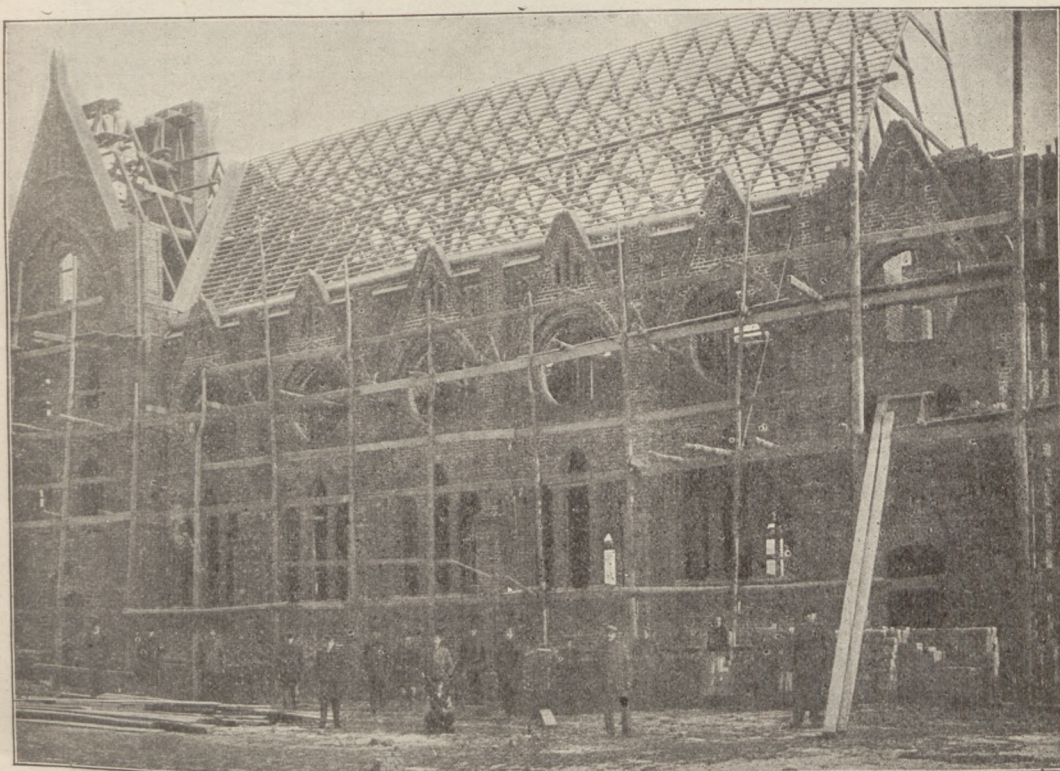
Warszawa. Budowa kościoła maryawickiego przy ul. Szarej.
