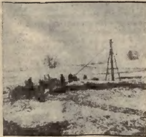
Holendry przy pracy.
