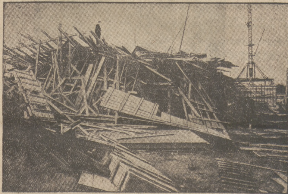
W Dortmundzie we Westfalji szalała bardzo gwałtowna wichura, która wyrządziła olbrzymie szkody. Budująca się świątynia katolicka śś. Piotra i Mikołaja, której mury zewnętrzne dochodziły już do 30 metrów wysokości, zawaliła się. Rycina powyższa przedstawia zawalisko.
