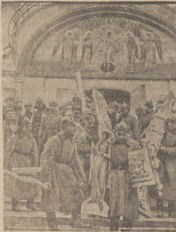
Niszczenie wewnętrzne sławnej Lawry Peczerskiej w Kijowie.
