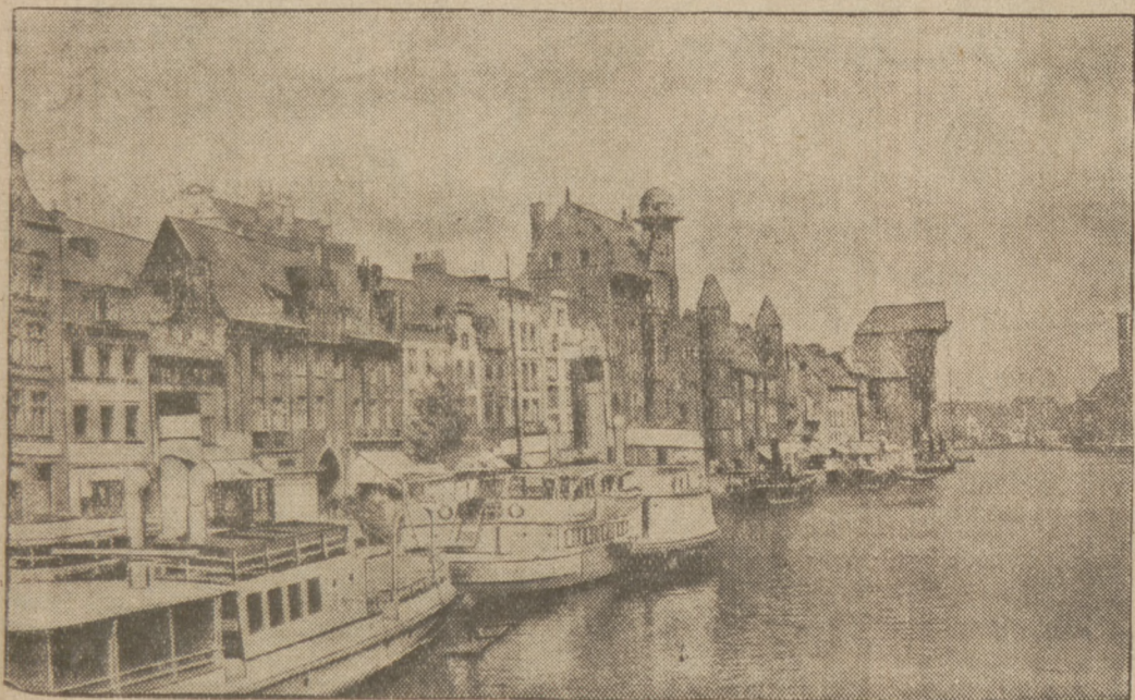
Port gdański — ujście Wisły — historyczna brama portu gdańskiego.
