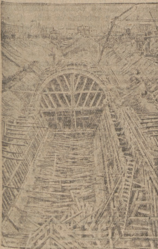
W miejscowości Św. Anna w pobliżu Antwerpii przesięgnięto imponującą budowę pod ręką Skalą dwóch tuneli przeznaczonych dla komunikacji pieszej i kolejowej. Powyżej widoczne są prace prowadzone około budowy jednego z tych tuneli.
