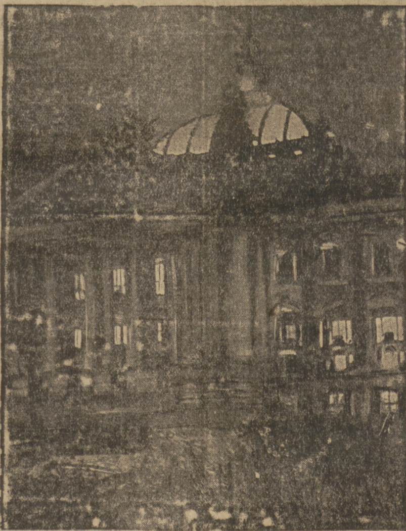
Widok z zewnątrz na budynek parlamentu podczas palenia się. Przez olbrzymią kopułę szklaną i okna przebija jaskrawy blask od szalejących wewnątrz płomieni.
