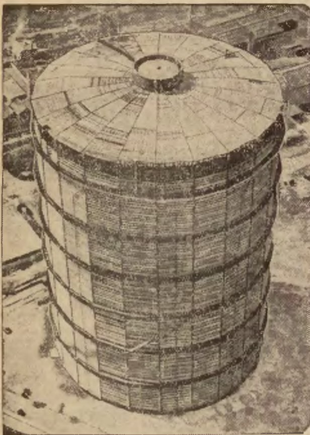
W Southell (Anglja) znajduje się olbrzymi zbiornik gazu wysokości 90 mtr., którego pojemność wynosi 300.000 mtr. sześciennych.
