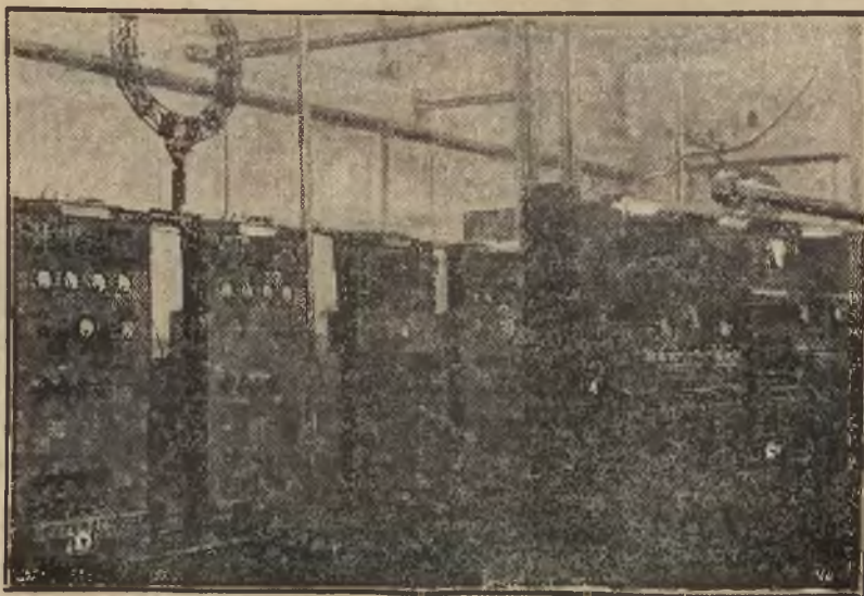
Amplifikatornia na ul. Zielnej, gdzie się potęguje dźwięki przed wysyłką do Raszyna; widać tu też rozdzielnicze telefoniczne, czynne przy transmisjach.
