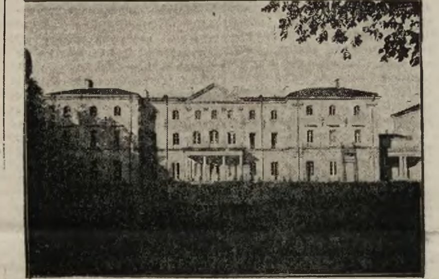
Fasada ogrodowa pałacu Branickich (stan obecny).
