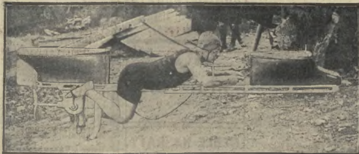
Jeuen z tanich wynalazków najświetlejszych, wypróbowanych na Sekwanie pod Paryżem przed kilku dniami przedstawia nasza rycina. Jest to jakby rower do pływania. Pływak, kręcąc nogami pedały, wprawia w ruch rodzaj małej śruby okrętowej, steruje zaś rękami.
