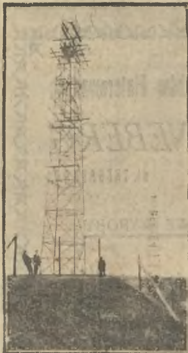
Olbrzymia wieża antenowa, którą buduje Polskie Radio. (Potrz str. 5).
