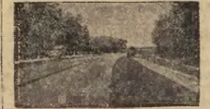
Nowa autostrada niemiecka o szerokości 19 m.
