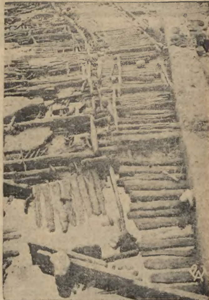
Na półwyspie jeziora biskupskiego w woj. Poznańskim rozkopuje się obecnie osadę przedhistoryczną (ok. 700—500 lat przed Nar. Chr.). Odkopano już 15 chat i 7 ulic. Ulice i chaty budowano z drzewa, ponieważ osadę założono na powierzchni bagniska, które posiada właściwości konserwujące drzewa, zachowały się doskonale dolne części chat, jak i ulice. Na zdjęciu dolna część jednej z największych chat.
