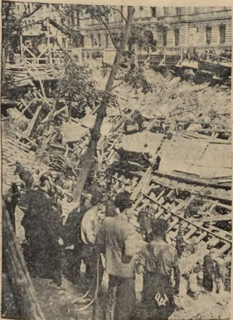
W Berlinie na ulicy Hermana Goeringa wydarzyła się straszna katastrofa. Zawaliła się jezdnia ponad budowanym wykopem podziemnej kolei, głębokości 30 metrów. Na zdjęciu miejsce katastrofy. Oddziały ratownicze prowadzą energiczną akcję, w celu wydobywania z pod gruzów 20 robotników, którzy znajdowali się w wykopie podczas katastrofy.
