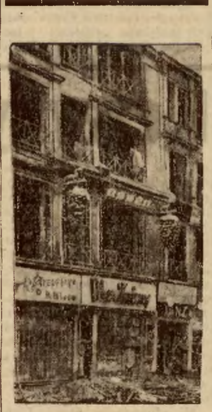
W Berlinie wybuchł groźny pożar na Friedrichstrasse. Ogień zniszczył trzy piętra olbrzymiego gmachu, w którym mieściło się wiele biur i lokali handlowych.
