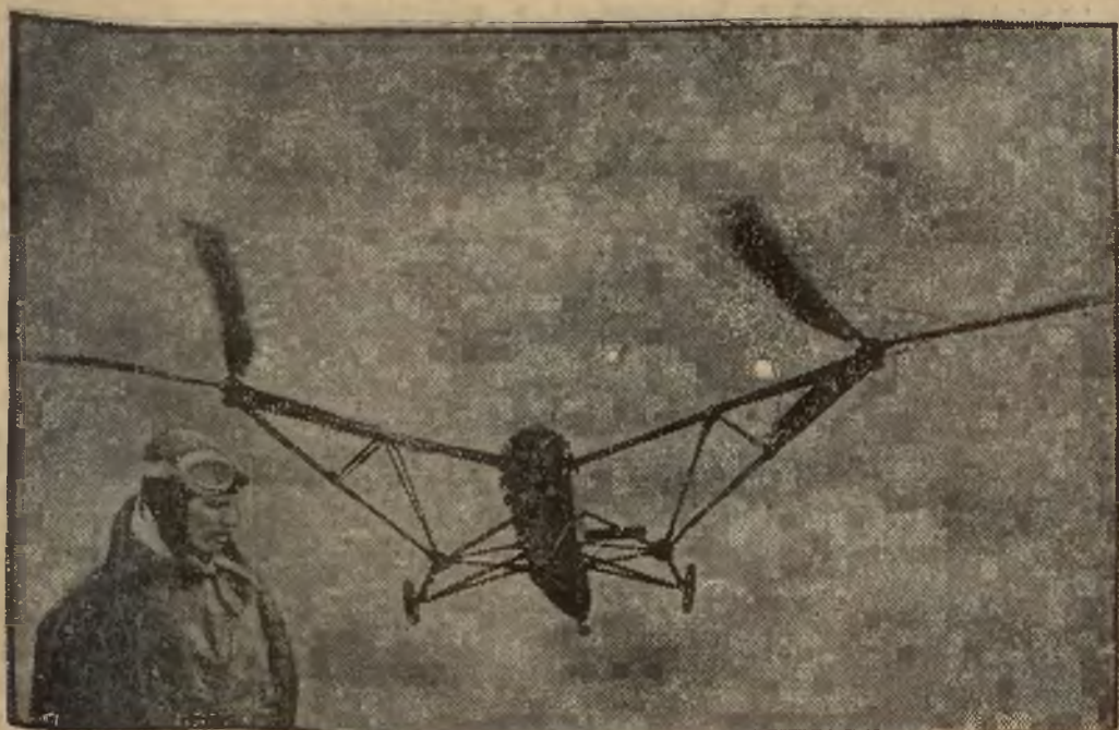
Pilot Rohls ustanowił na wirowcu, konstrukcji inż. Fockego szereg nowych rekordów światowych, dla tej kategorii maszyn. Rohls osiągnął szybkość 122,5 klm. na godz. i wzbił się na wysokość 2,5 klm.
