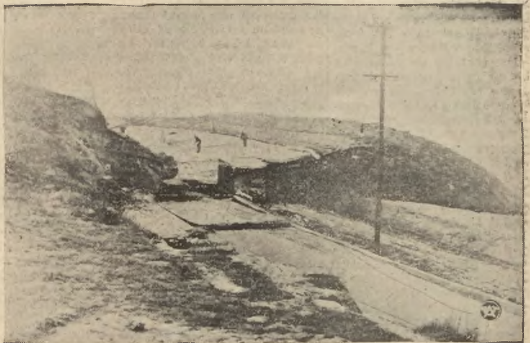
Pod San Francisco wskutek osunięcia się ziemi, nastąpiło opadnięcie szosy betonowej o 20 m., co spowodowało przerwanie przewodów kanalizacyjnych, gazowych i kabli telefon.
