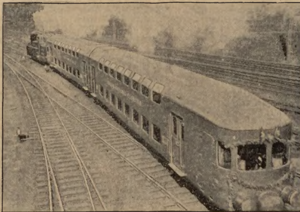
Na linii kolejowej Hamburg — Lubecka wprowadzono tytułem próby aerodynamiczny pociąg pośpieszny, składający się z dwupiętrowych wagonów. Pociąg posiada 300 miejsc i rozwija szybkość 130 km, na godzinę.
