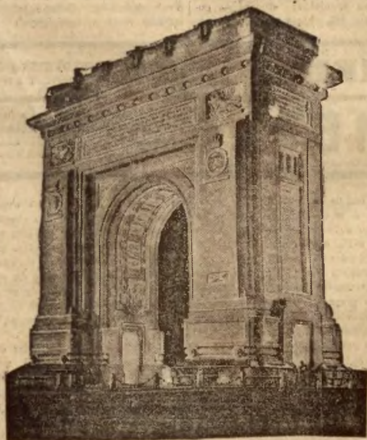
W Bukareszcie wzniesiono z marmuru i granitu łuk Triumfalny, którego budowę rozpoczęto w r. 1927.
