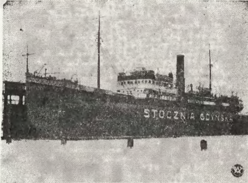
Remont S/S „Łódź“ w stoczni gdyńskiej.
