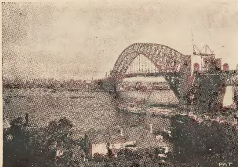
Ponad najpiękniejszą zatoką świata miasto Sydney (Australia) wybudowało olbrzymi jednoarkadowy most. Most ten oddany będzie oficjalnie dla ruchu dnia 19 marca 1932 r. Ma on 3,770 stóp długości i waży 50,200 tonn. Na moście tym znajdują się 4 tory tramwajowe, 6 torów dla ruchu kołowego i 2 szerokie chodniki.
