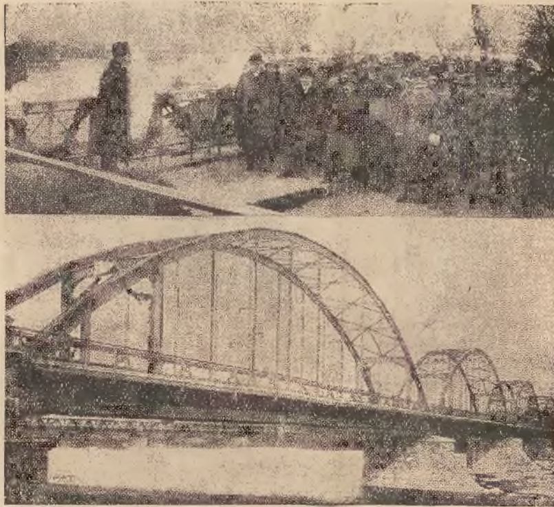
Onegdaj odbyła się uroczystość poświęcenia i otwarcia nowowybudowanego mostu szosowego na Narwi pod Zegrzem, łączącego powiat warszawski z powiatem pułuskim. Zdjęcie nasze przedstawia (na górze) p. Woj. Twardo, przemawiającego przed przecięciem wstążki, (na dole) ogólny widok mostu.
