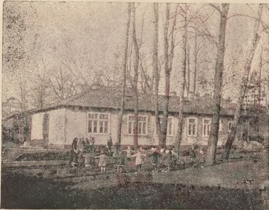
W listopadzie b. r. otwarte zostały na G. Śląsku liczne przedszkola. W Tarnowskich Górach pomieszczone jest ono w budynku nawskróś nowoczesnym, zbudowanym z masy polomitowej systemu dr. Hofmoka. Uczęszcza do niego przeszło 40 dzieci. — Zdjęcie nasze przedstawia grupę dzieci, bawiących się przed budynkiem przedszkola w Tarnowskich Górach.
