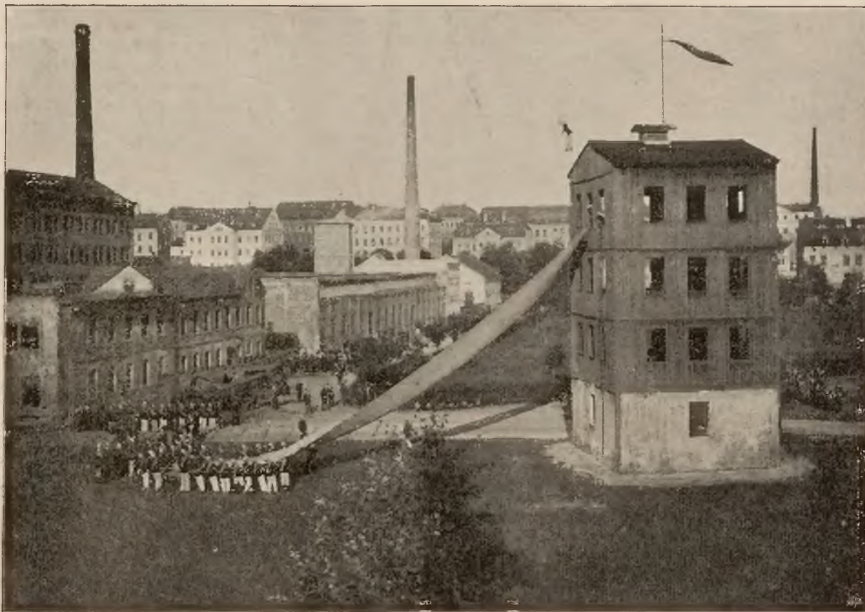
RATOWANIE LUDZI W CZASIE OGNIĄ Z WYSOKICH DOMÓW ZA POMOCĄ PŁACHTY BEUERA.
