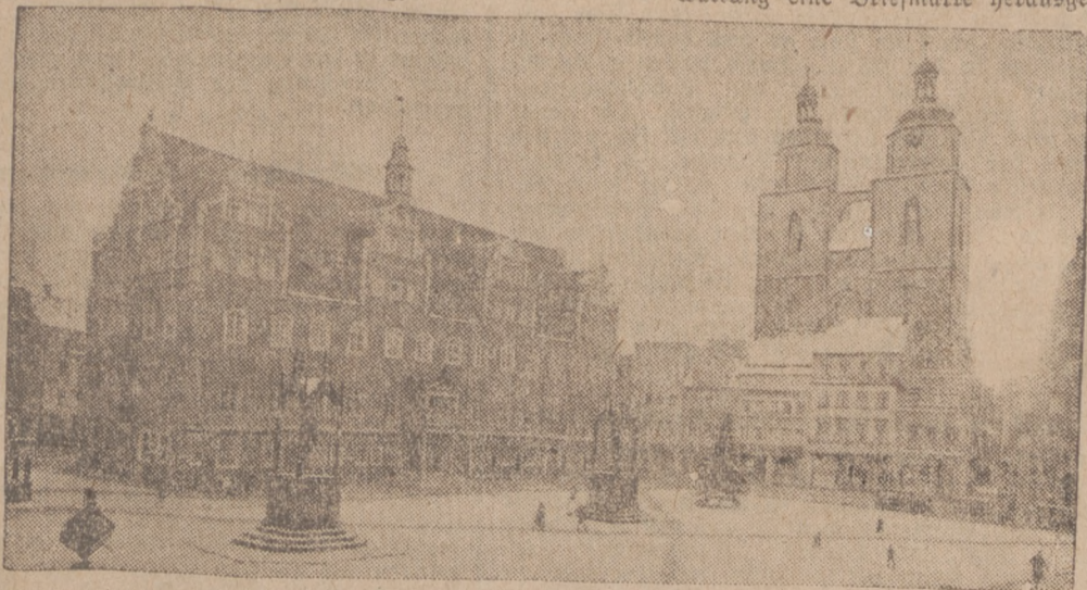
Luthers Predigtkirche nach dem Umbau
