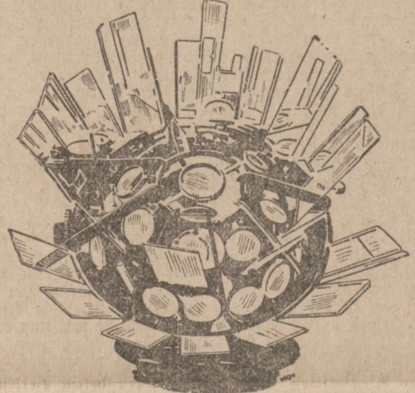
Eine Sonnenkraft-Maschine, die mit Spiegeln und Brennläsern die Strahlen einfängt und auf einen Mittelpunkt vereinigt. Das Gerät hat aber wohl nicht alle Erwartungen erfüllt.
