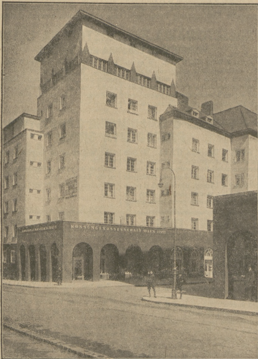
Dom mieszkalny dla robotników, wybudowany staraniem Samorządu Socjalistycznego.
