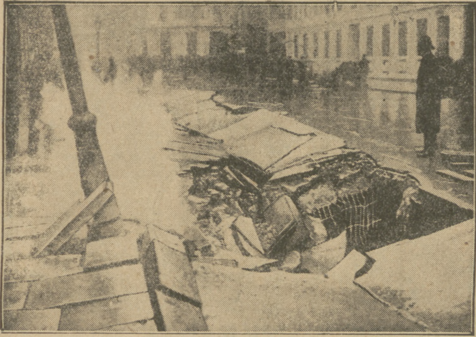
Z powodu wybuchu gazu palnego pod ziemią, ulice i domy Londynu zostały poważnie uszkodzone. Na zdjęciu widok jednej z głównych ulic Londynu po wybuchu.
