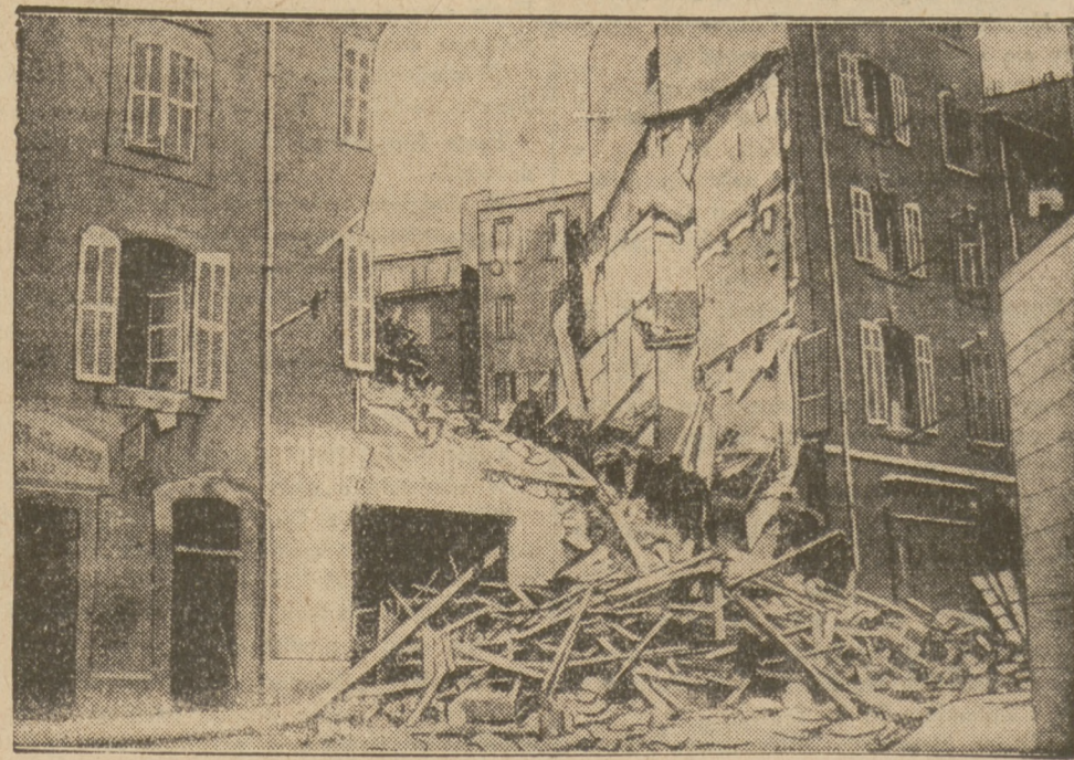
Jeden z licznych domów zburzonych przez szalejącą burzę.
