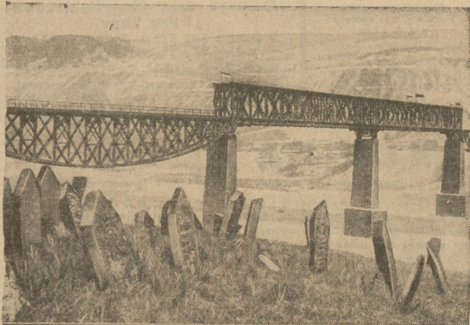
Most kolejowy na Dniestrze na granicy między Polską i Rumunją, zniszczony podczas wojny, został odbudowany i oddany do użytku publicznego.
