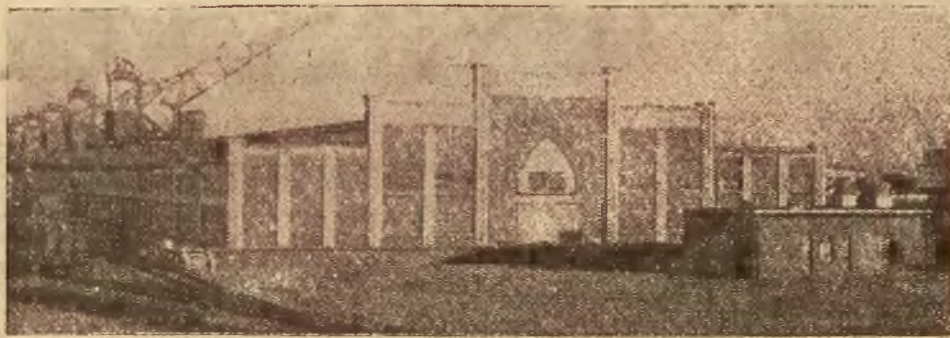
Na zdjęciu naszym widzimy standardowy magazyn bawelniany na Nabrzeżu Stanów Zjednoczonych o powierzchni 12.000 m kw., obsługiwany przez 8 dźwigów półportalnych o nośności 3 tony każdy.
